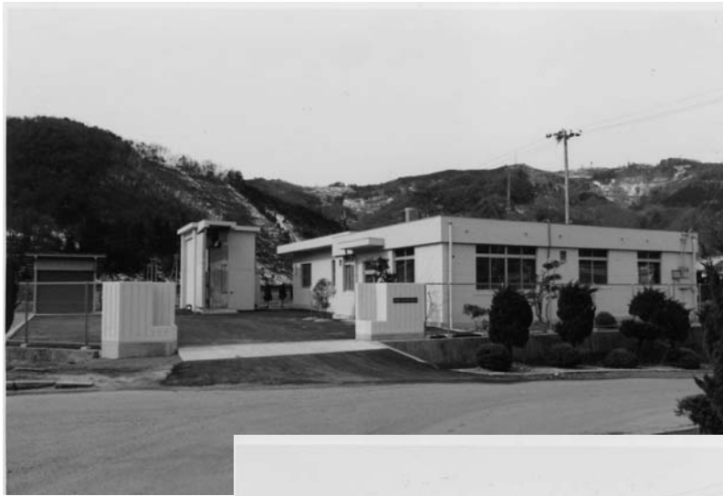
検査所の全景
