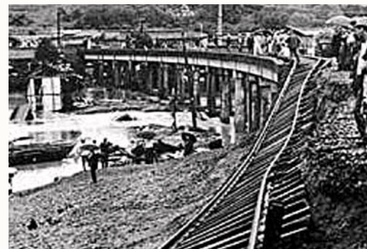
み よし し どうしやう こう かわ だくりゅう 三次市では道床が江の川の濁流にえぐりと取られ、三江南線の線路が曲がった。
