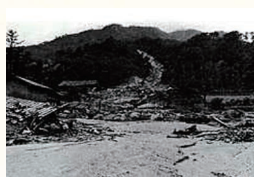
しょうばらし ごんげん やま ど せきりゅう はっ せい ぜん かい か おく 庄原市の権現山で土石流が発生。全壊家屋2戸、死者2名、負傷者2名の被害が出た。
