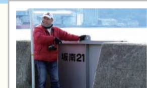
大きな波がくると閉めて水害を防止する防波とびらがある。
